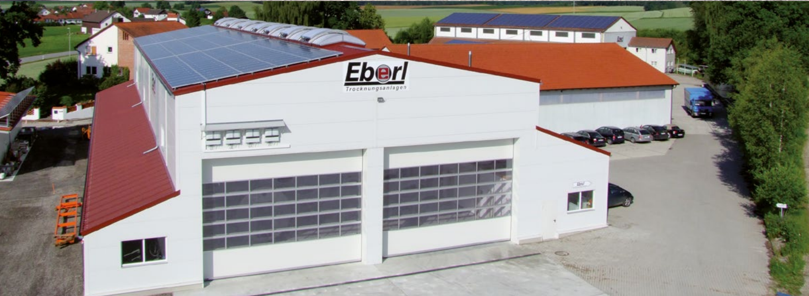
Местонахождение фирмы Эберл Трокнунгсанлаген г.Боденкирхен (Бавария)
