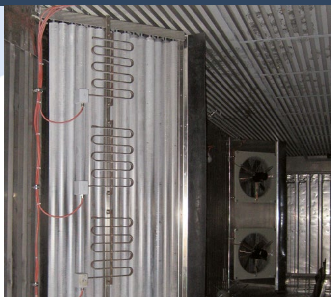
Электрический нагреватель и нагрев горячей водой
