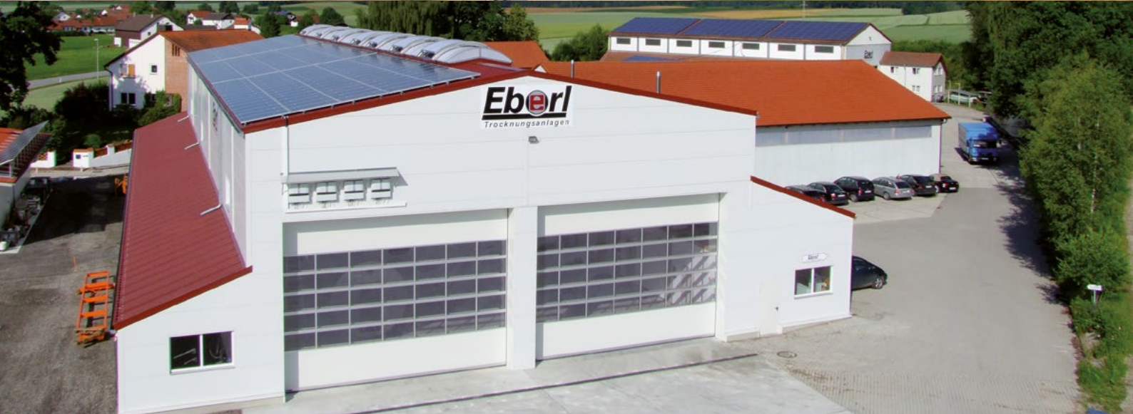
Siedziba firmy EBERL Trocknungsanlagen w Bodenkirchen (Bawaria)
