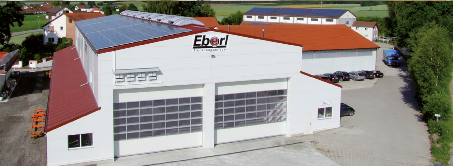
Siedziba firmy EBERL Trocknungsanlagen w Bodenkirchen (Bawaria)
